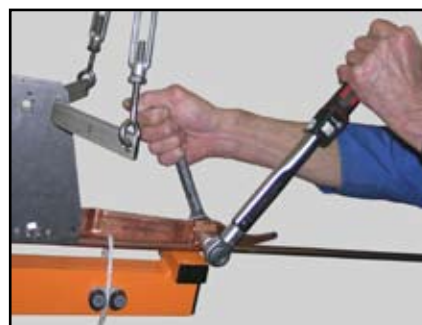
20. Ender trekkes til med 50 Nm, kontramutter med 20 NM.
