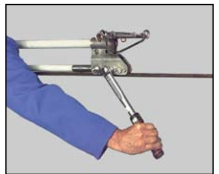
7. Skruer trekkes til 3 ganger med moment 50 Nm.
